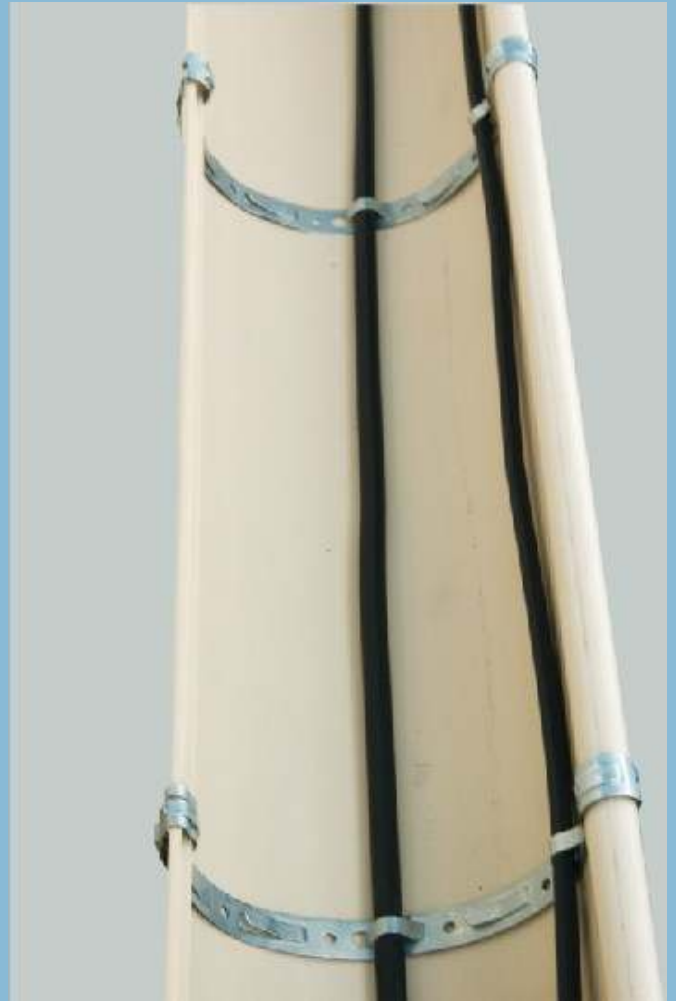
Mocowanie przewodów grzejnych w rynnie przy pomocy taśmy ELEKTRA TMS
